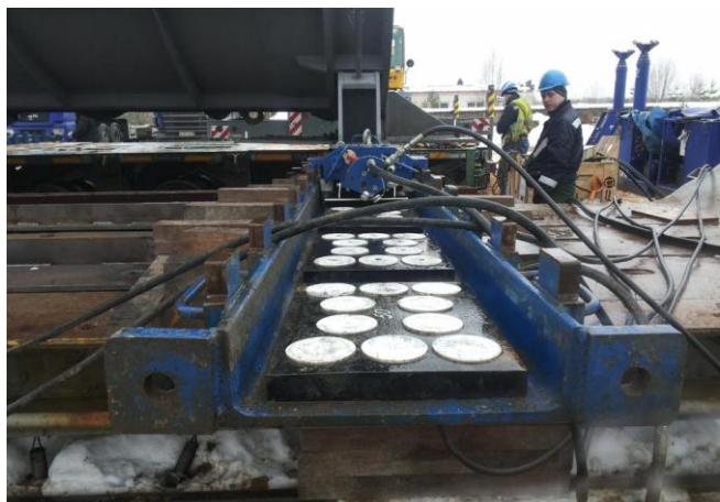
Перемещение груза с помощью «СКАТа»
